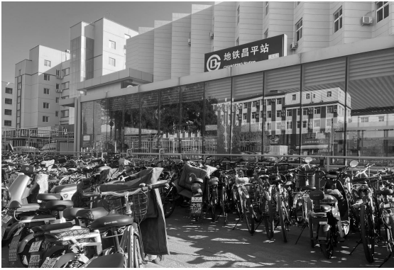
改造潜力点位1：地铁站立面
